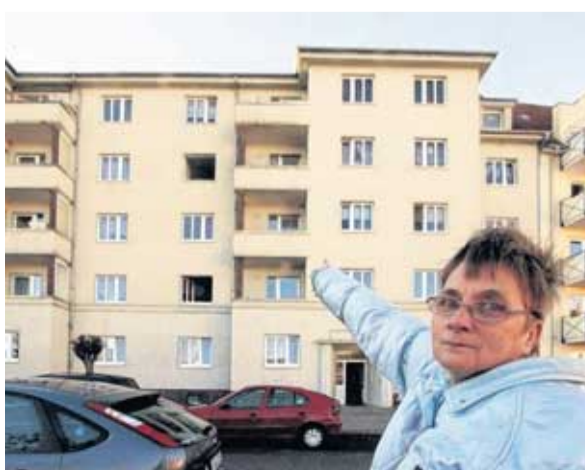
Mieterin Angelika Naumburger wurde mit der Drehleiter der Döbelner Feuerwehr von ihrem Balkon in der Grimmischen Straße 11 gerettet. Foto: Wolfgang Sens
